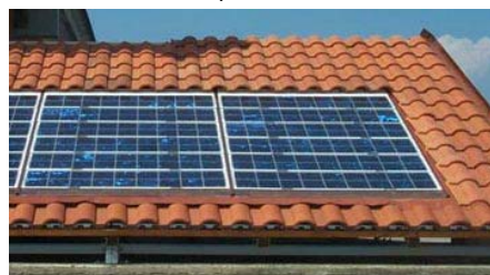
Esempio impianto integrato in copertura di edificio
